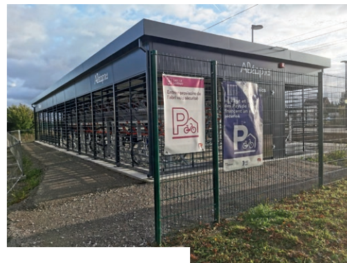
Abri vélo à la gare de Savenay
